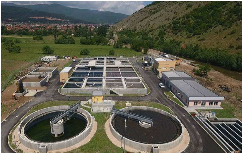
Kläranlage Kičevo (Mazedonien)
